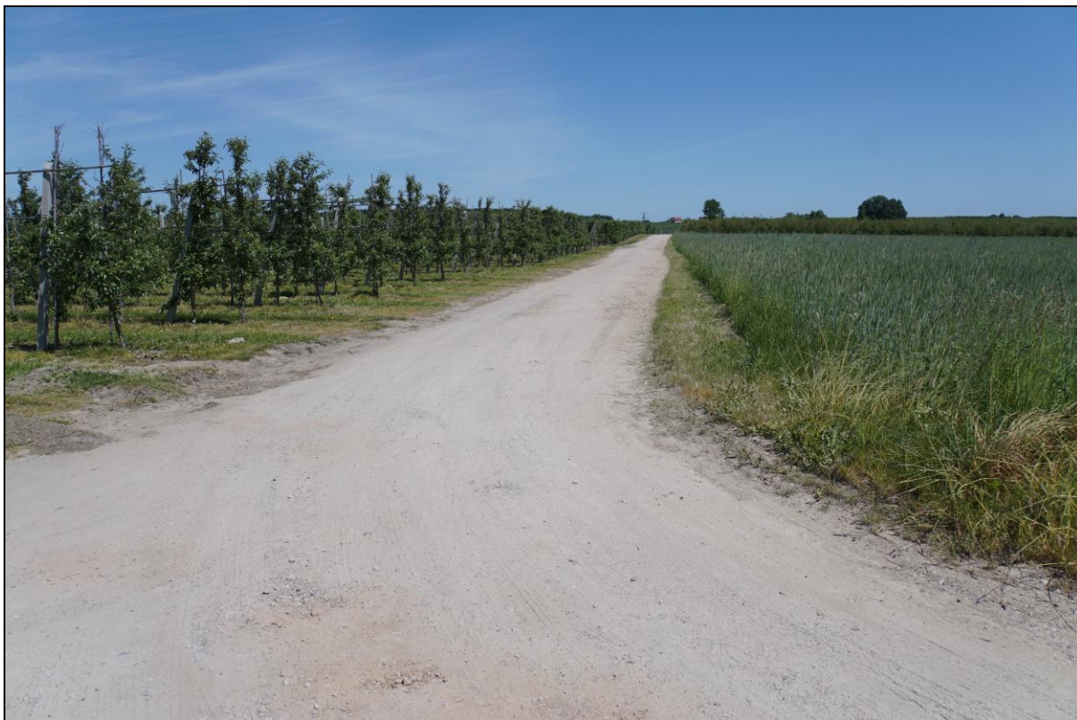
Droga wewnętrzna (działka 236) – widok z drogi gminnej nr 113203E w kierunku wschodnim.
