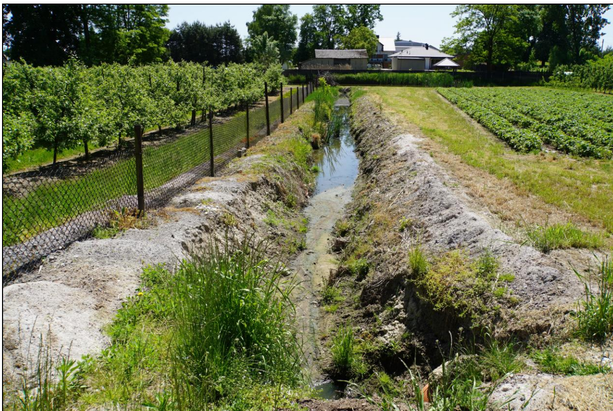
Rowy zbierające wody opadowe do stawów położonych w najniższej części obszaru - widok z drogi wewnętrznej (działka 278) w kierunku południowym.
