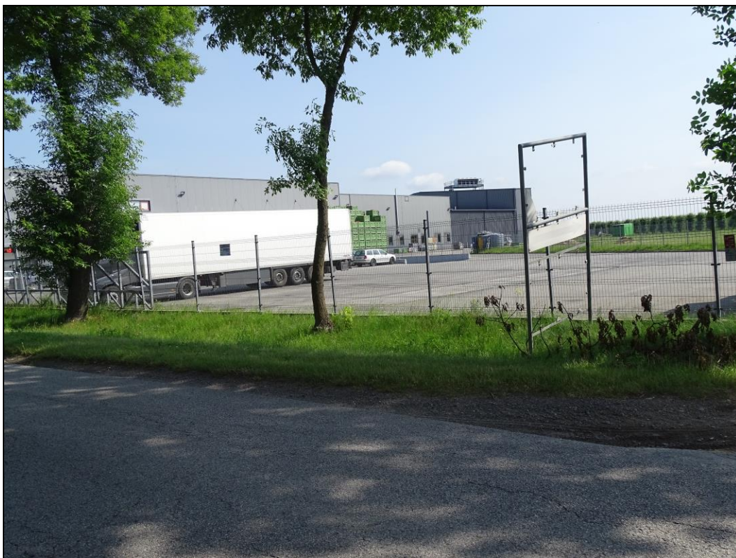
Obiekt produkcyjny (przechowalniczo-logistyczny z sortownią owoców) usytuowany na działkach nr 176, 177/1, 177/2 - widok od strony drogi powiatowej Nr 4122E w kierunku północno-wschodnim.
