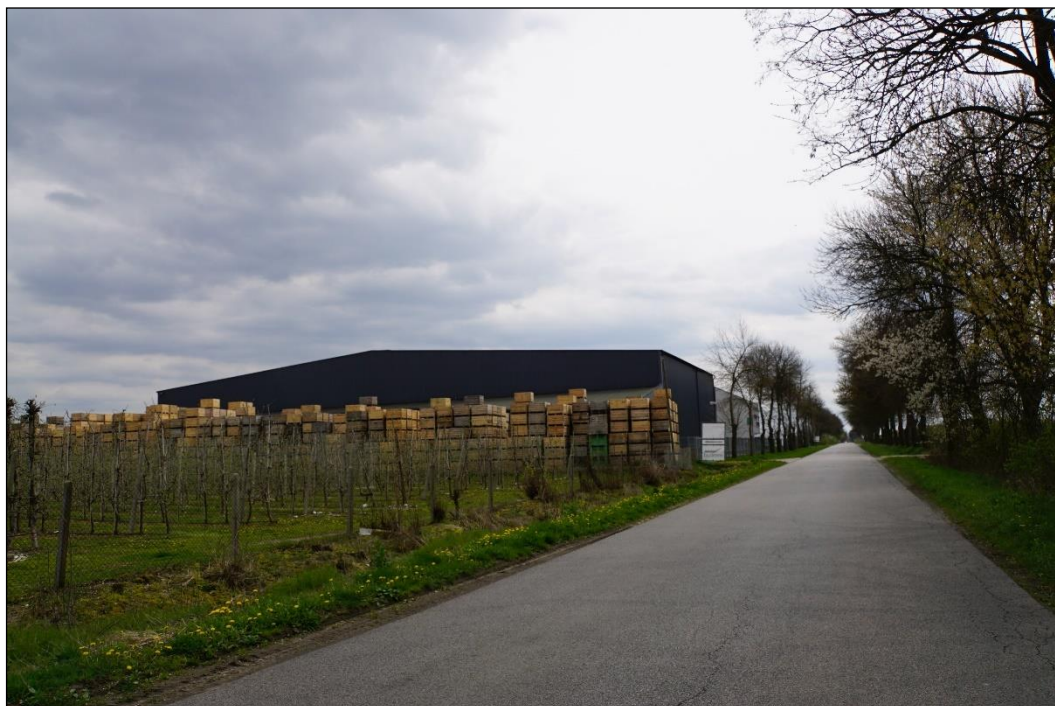
Obiekt produkcyjny (przechowalniczo-logistyczny z sortownią owoców) usytuowany na działkach nr 176, 177/1, 177/2 - widok od strony drogi powiatowej Nr 4122E w kierunku południowym.
