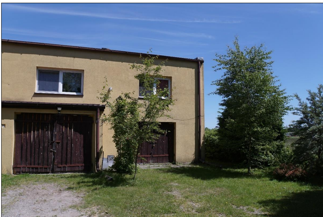
Budynek mieszkalny wielorodzinny na działce nr 383/3 – widok od strony drogi wewnętrznej w kierunku wschodnim.
