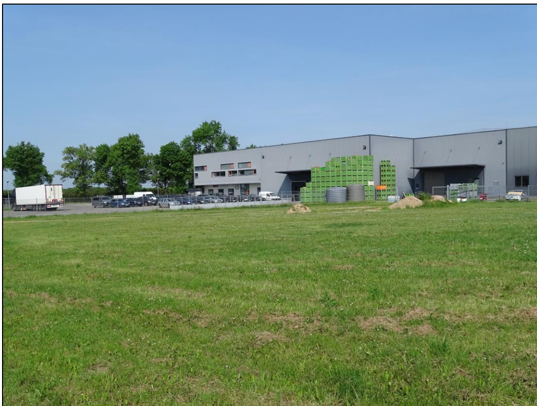
Obiekt produkcyjny (przechowalniczo-logistyczny z sortownią owoców) usytuowany na działkach nr 176, 177/1, 177/2 - widok od strony drogi wewnętrznej w kierunku północno-zachodnim.
