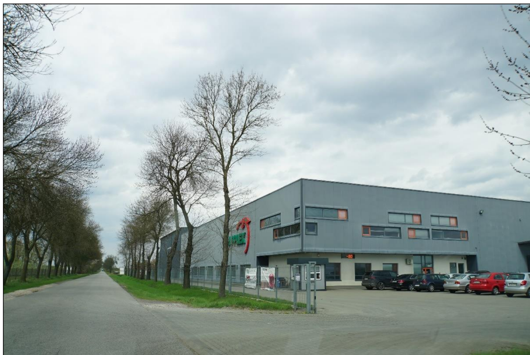
Obiekt produkcyjny (przechowalniczo-logistyczny z sortownią owoców) usytuowany na działkach nr 176, 177/1, 177/2 - widok od strony drogi powiatowej Nr 4122E w kierunku północnym.
